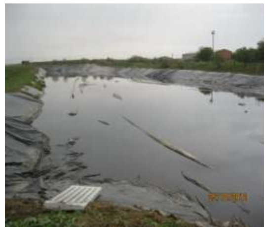
Lacul de acumulare a dejecțiilor animaliere de la fabrica de porcine. s. Roscani. r. Anenii Noi
